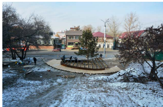
Строительные работы (ноябрь 2016 года)
